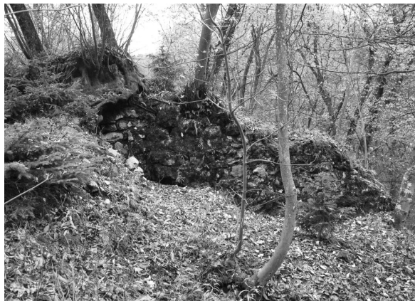
Sl. 5: Gradišče na Drago. Južni zid palacija, severno lice (foto: Andrej Gaspari).
